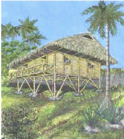
CONSTRUIDA TOTALMENTE CON TRONCOS Y VARAS DE BAMBÚ TANTO EN SU ESTRUCTURA QUE SE DEJA APARENTE POR EL EXTERIOR, COMO EN LOS Muros ARMADOS CON DOBLE CAPA DE VARAS DELGADAS DE BAMBÚ APLANADAS Y PINTADAS INTERIORMENTE EL PISO SOBRE LA ESTRUCTURA DE BAMBÚ CONSISTE EN UNA LOSA DE FERROCEMENTO O UNA TARIMA DE DUELA RECUBIERTA POR UN PISO CON CORTEZA DE BAMBÚ.
